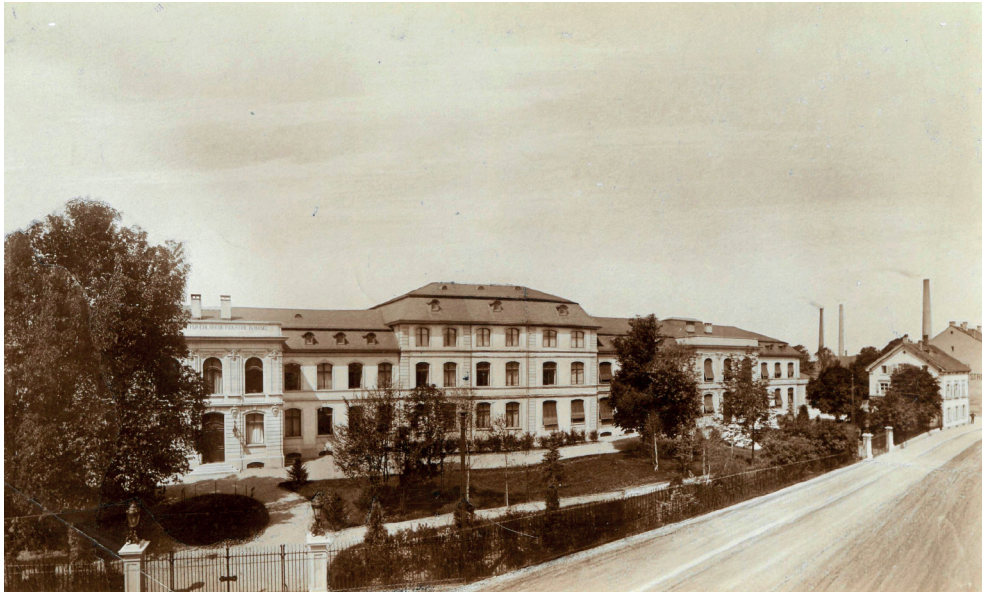
Abb. 6. Basel, Ansicht des erweiterten Verwaltungsgebäudes der Gesellschaft für Chemische Industrie Basel von der Klybeckstrasse, Fritz Stehlin, 1915–1931. © Novartis-Archiv, Bestand Ciba, T 1.01.3.
