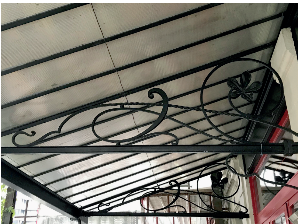
Fig. 4. Une marquise de l'ensemble Gare des Eaux-Vives. Photographie de Leïla el-Wakil.
