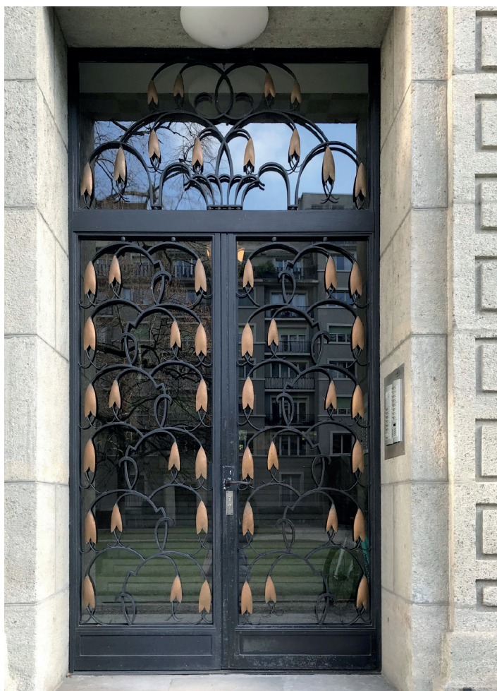
Fig. 3. Une porte d'entrée du square Montchoisy. Photographie de Leïla el-Wakil.
