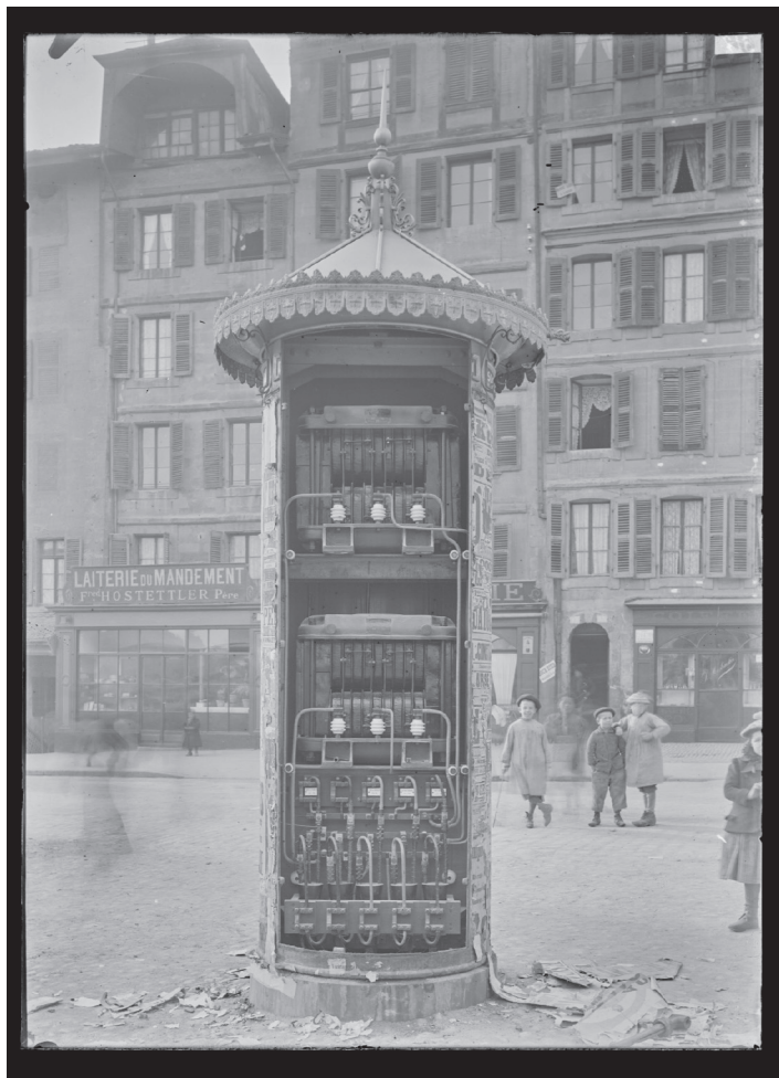
Fig. 2. Transformateur électrique à la place St-Gervais, 1905. Bibliothèque de Genève / Centre d'icographie genevoise, SIG n13x18 00317.
